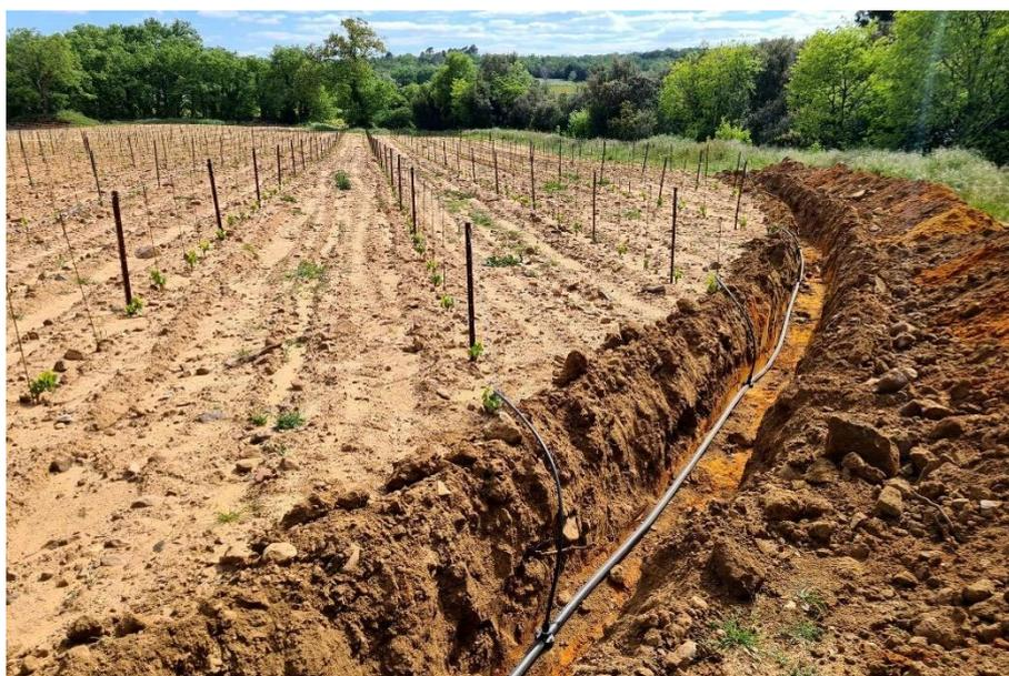
*Figure 48 - Installation d'un système d'irrigation sur une parcelles de plantiers. 04/2024. La Capelle et Masmolène.*
